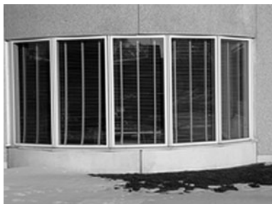
Metalowe poziome żaluzje ograniczają w razie potrzeby nasłonecznienie pomieszczeń szkolnych
